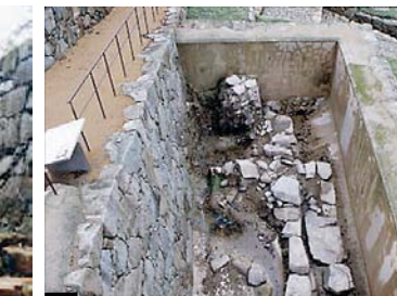
13 石垣改修の露出展示:5回も石垣の改修工事を行なっている跡が見られます。
