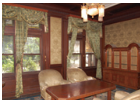
■ 応接間1（改修前）
